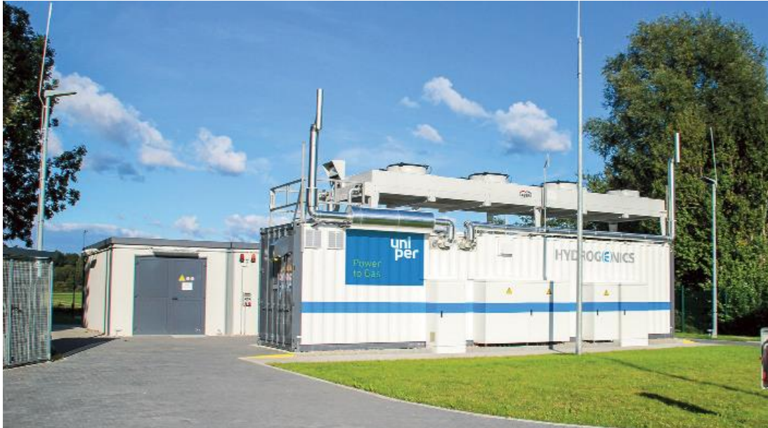
Abbildung 1: Elektrolyse Reitbrook - Vor-Ort-Montage abgeschlossen
